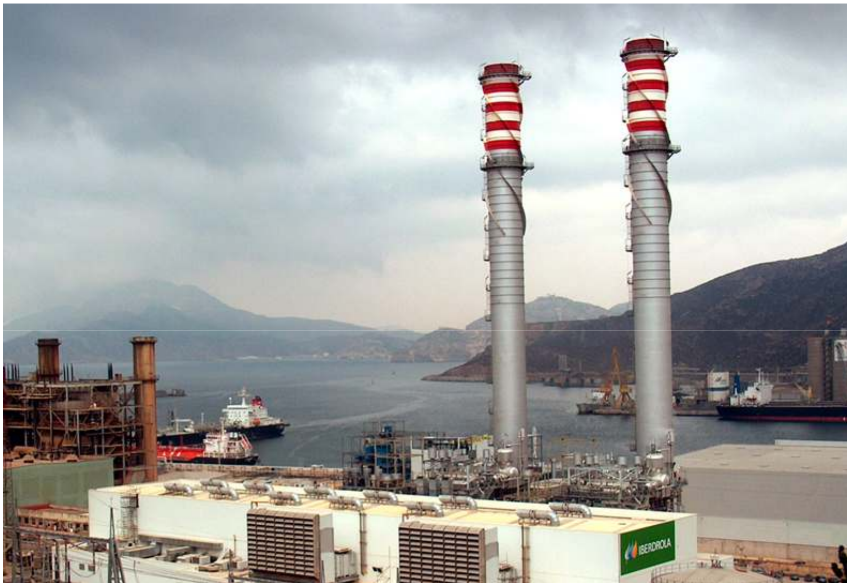
Ciclo combinado de Iberdrola en Escombreras (fuente: http://www.iberdrola.es )
