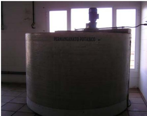
*Depósito de mezcla y dosificación de permanganato fuera de servicio*
