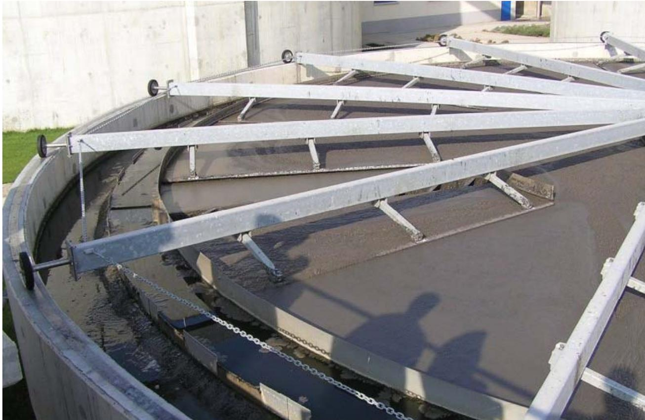
Un caso particular del espesamiento por flotación es aquel en el que se emplea aire presurizado. El agua es de reciclado y la presurización óptima se consigue con 3 – 5 atm en el tanque, para conseguir burbujas de 50 a 100  $\mu\text{m}$ .
