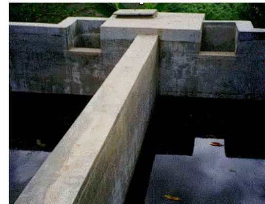
Ventajas → El mecanismo biológico de esta filtración es muy efectivo para la eliminación de microcontaminantes.
