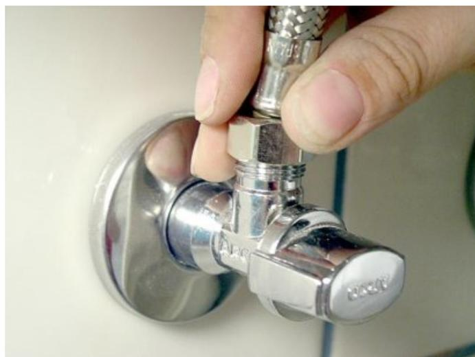
Fig. 56. Conexión latiguillo con llave de corte de aparato sanitario.
