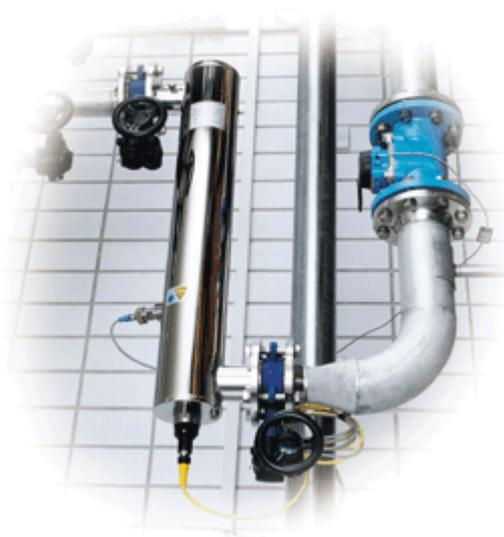
Fig. 79.B. Tratamiento Ultravioleta (UV)<sup>12</sup>
