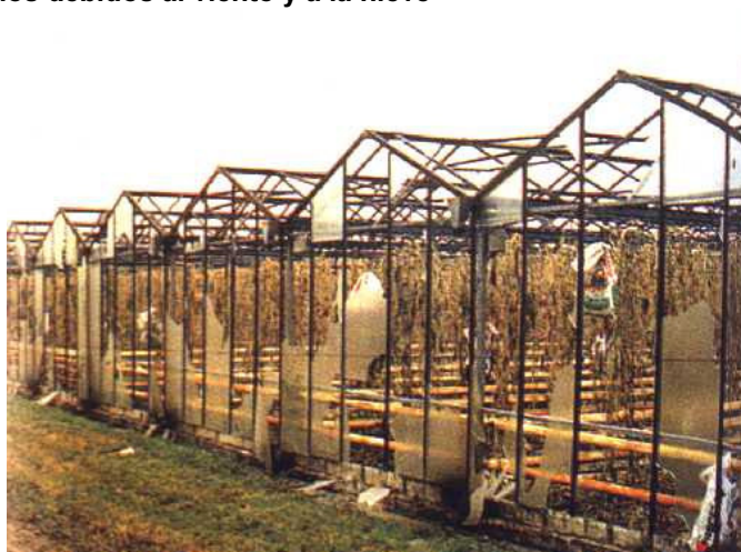
Figura 13a. Daños en un invernadero de cristal por rotura de los cristales
