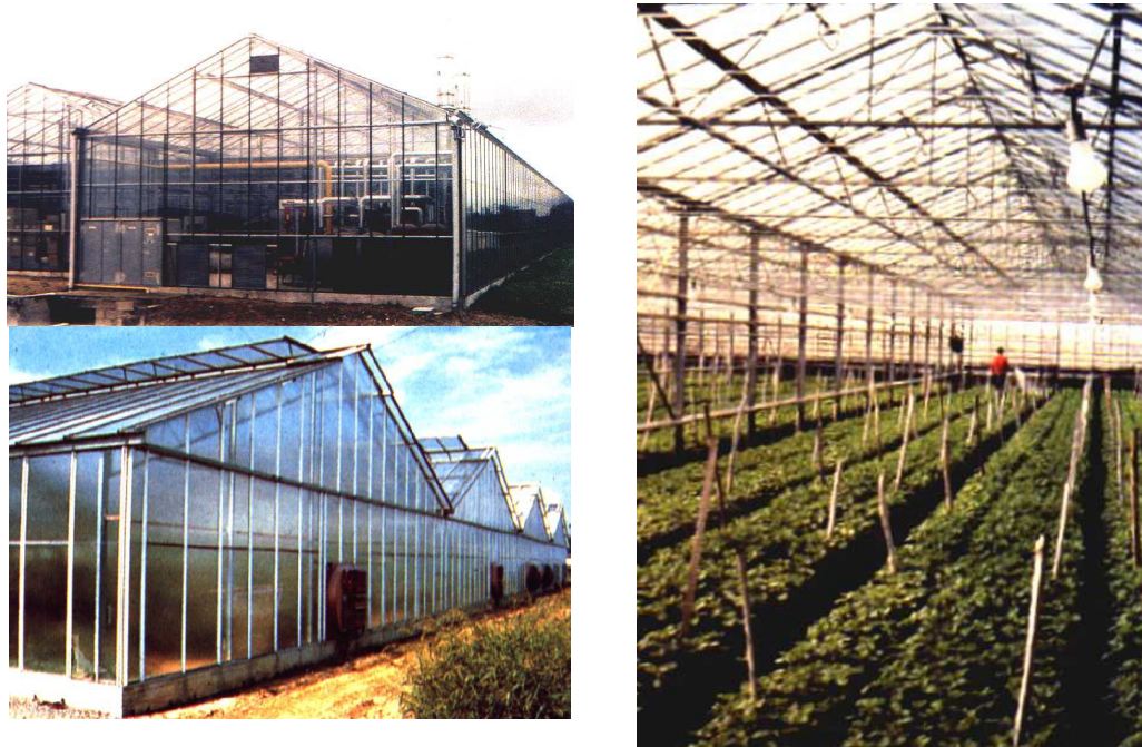
Figura 6. Invernaderos con anchura mediana de luz (9m y 12 m de anchura), utilizados principalmente para cultivos de flor cortada y plantas ornamentales cultivadas en maceta. Casi todos tienen ventilación en cumbrera.
