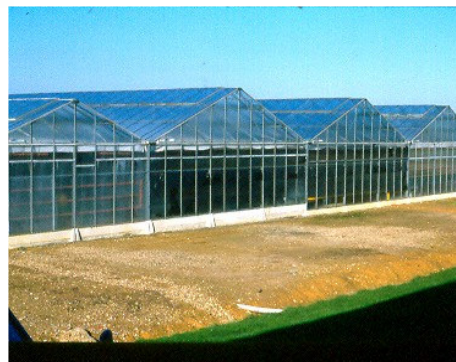
Figura 12. Invernadero con 6,40 m de luz (Empresa CMF. Francia)
