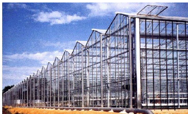
Figura 21. Vista de una ventana de ventilación (con un panel) en un invernadero Venlo.
