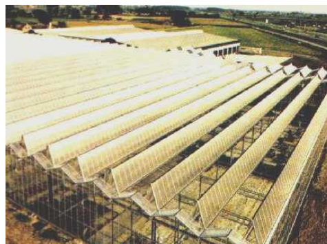
Figura 20. Un modelo de invernadero Venlo con techo “descapotable”
