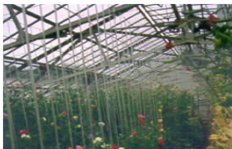
Figura 10. Invernadero de cristal para zonas frías con ancho medio de luz (9 m) y con estructura reforzada resistente a altas cargas de nieve (típicas de Europa del Norte y Japón)
