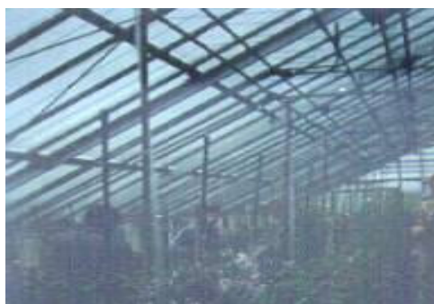
Figura 22. Invernadero de cristal asimétrico (Japón), con luz mediana (6 m) y estructura resistente a altas cargas de nieve, diseñado para zonas frías.
