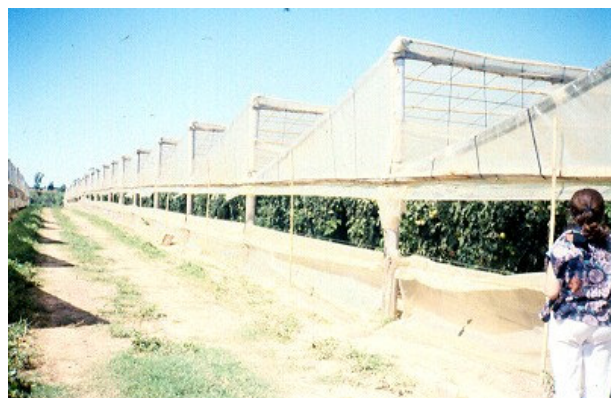
Invernadero de madera con cubierta en dientes de sierra.
