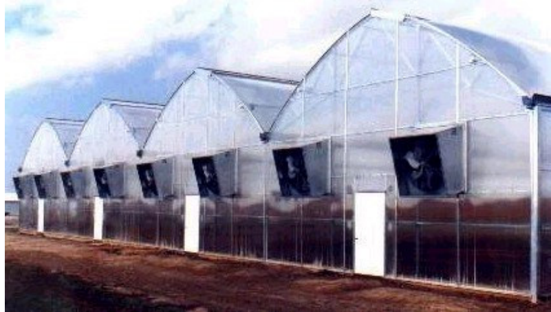
Invernadero multicapilla con cubierta de arco gótico ("quonset arch")
