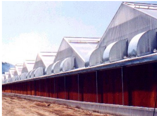
Invernadero multicapilla con cubierta a dos aguas.
