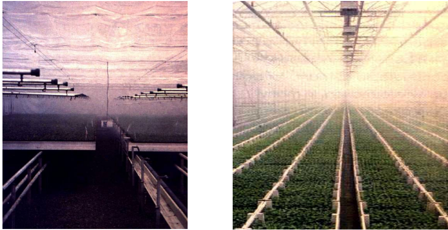
Figura 17. Sistemas de nebulización (o “fog” systems) con rampas provistas de boquillas de pulverización del agua a alta presión.
