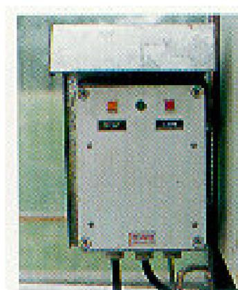
**Figura 11b.** Analizador de CO (necesario en caso de enriquecimiento a partir de gases de combustión).
