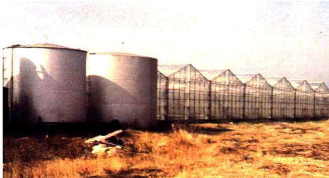
**Figura 9.** Tanques de almacenamiento de CO<sub>2</sub> frío para una explotación de 3 ha de invernaderos.
