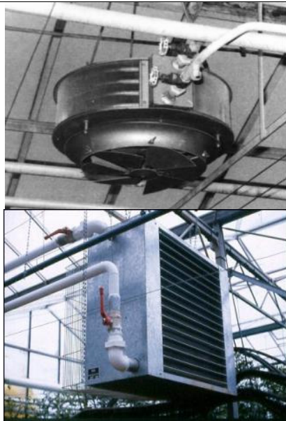
Figura 3. Aerotermo baja temperatura con toma de aire vertical (arriba) y toma de aire horizontal (abajo).
