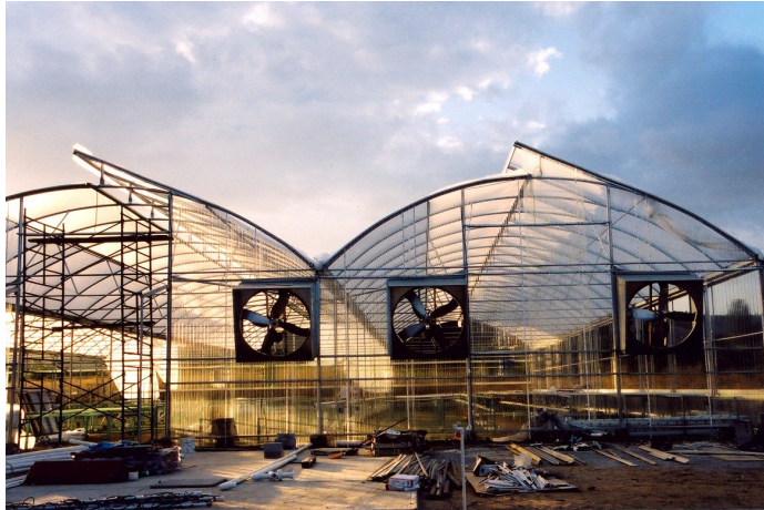
Ventilación cenital y extractores
