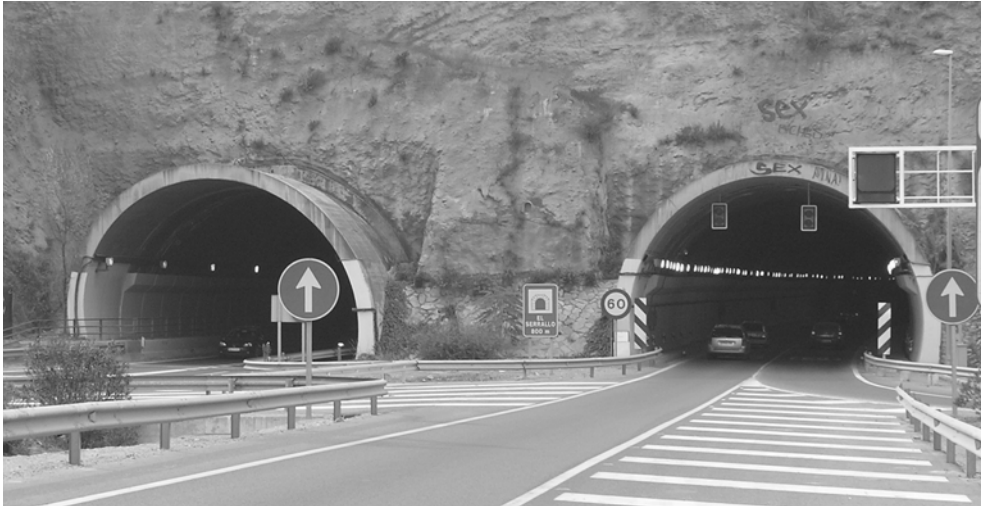
Fig. 10.1. Túnel de El Serrallo. Granada
