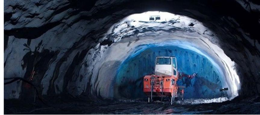
Equipos de perforación en frentes de galería
