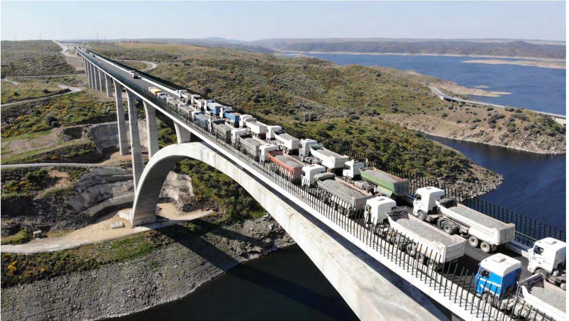
Viaducto del Tajo (FF. CC.). Prueba de Carga
