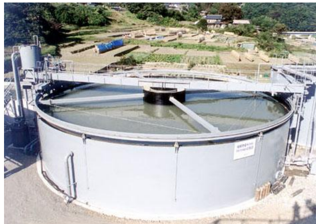
Fig.11.21: Tuberías de alimentación al pozo central.
