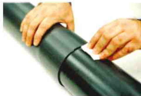
4. Retirar y limpiar el adhesivo sobrante. Esperar el tiempo recomendado para el secado.
