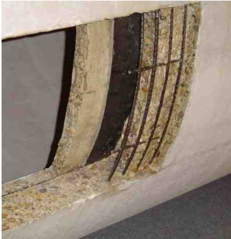
Tubo de hormigón armado con camisa de chapa de acero
