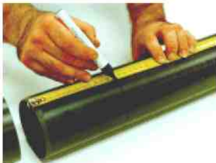
1. Achaflanar, redondear y desbarbar el tubo. Marcar en el tubo la distancia a introducir en la unión.
