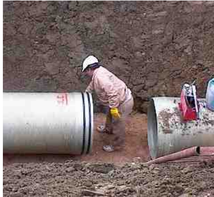
Unión con enchufe y extremo liso (doble anillo)
