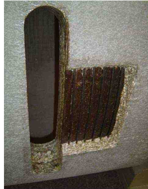
Tubo de hormigón postesado con camisa de chapa de acero revestida
