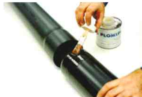
2. Limpiar el interior y el exterior. Aplicar adhesivo en la embocadura y en la zona marcada extremos a unir.
