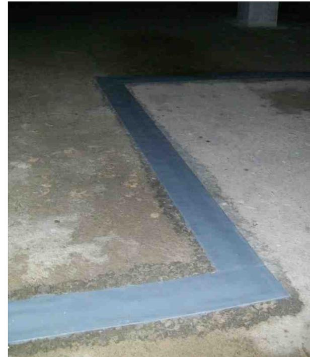
*Tratamiento de juntas de dilatación en techo, pilares y solera mediante banda continua de absorción de movimientos, fijada con adhesivo de alta eficacia (sistema TRICOFLEX®)*
