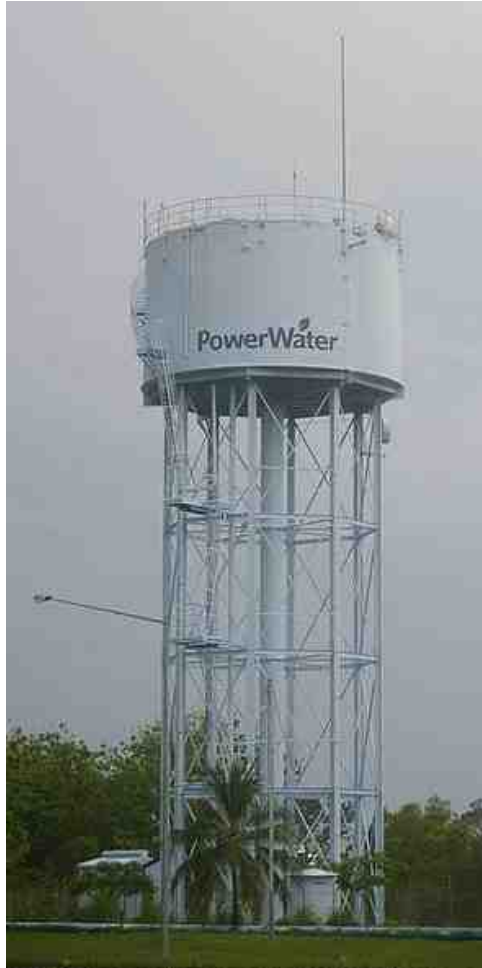
Depósito elevado (Darwin, Australia)
