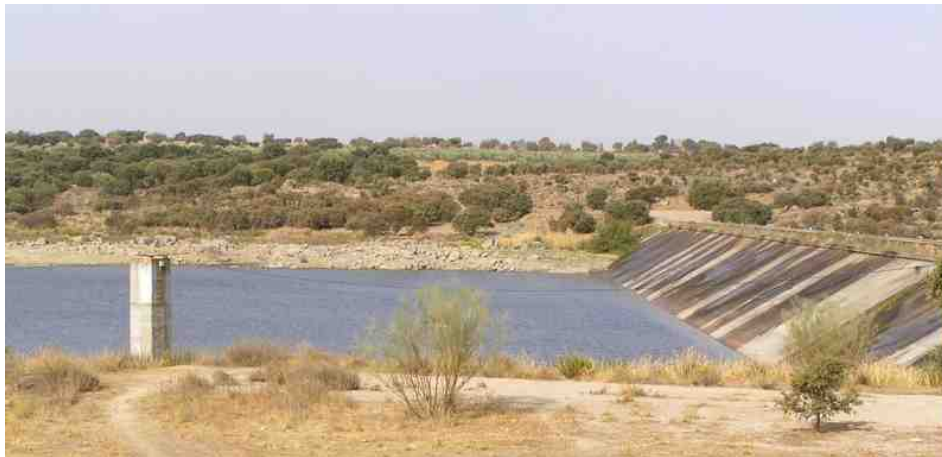
Vista del embalse de Guajaraz, con torre de toma para la captación de agua bruta
