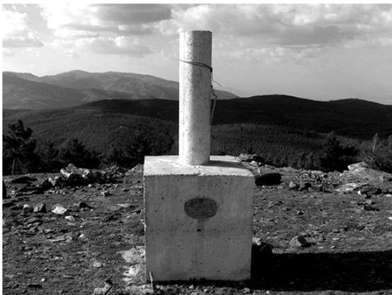
Fig. 2.1. Vértice geodésico
