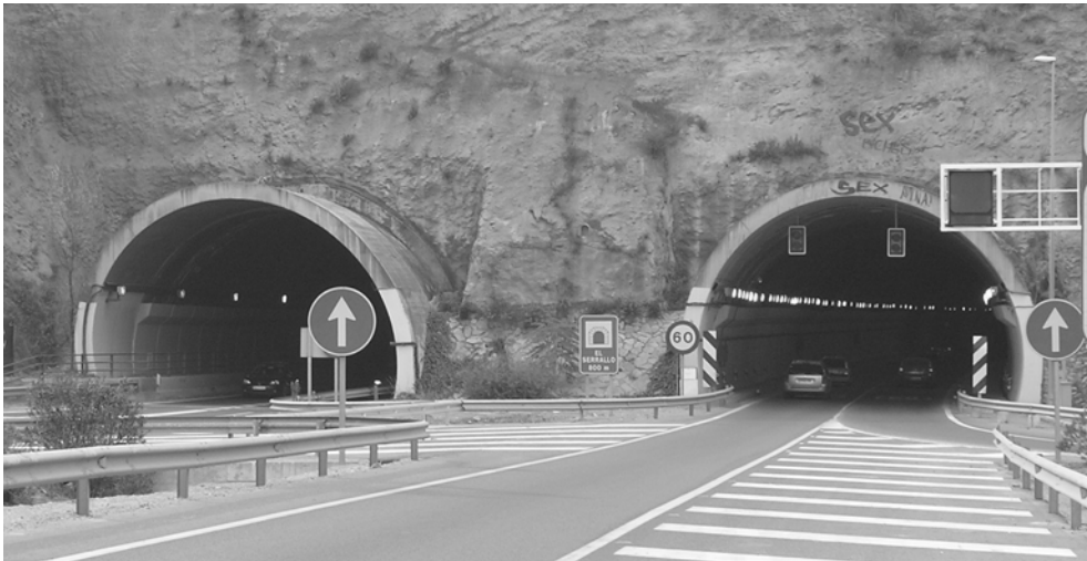
Fig. 18.1. Túnel de El Serrallo. Granada
