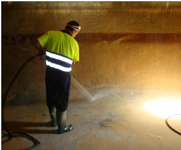
Limpieza del depósito municipal de agua (La Nucía, Alicante)
