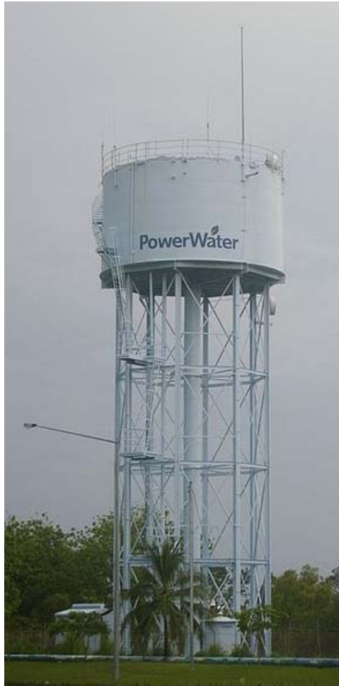
Depósito elevado (Darwin, Australia)
