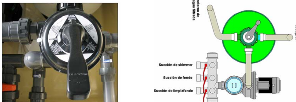
Fig. 3.6 Válvula selectora de 6 vías 12
