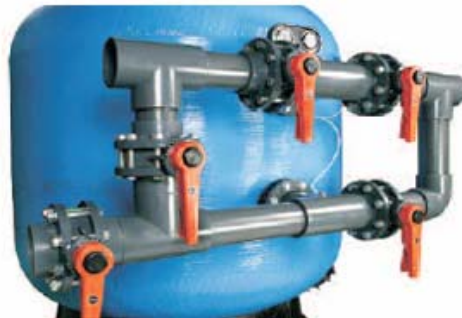
FIG. 3.7 Batería de válvulas en filtro 14
