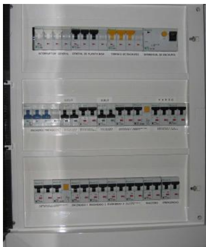
Figura 4.40: Cuadro general de mando y protección de servicios generales [4].
