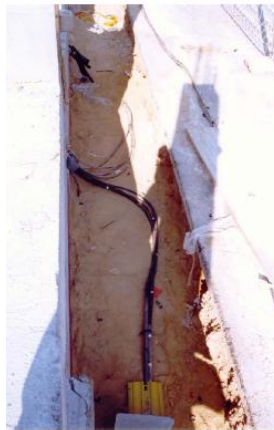
Figura 3.25: Red de distribución subterránea con cables directamente enterrados.
