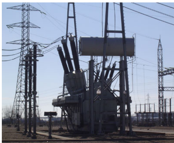
Figura 3.9: Subestación Elevadora de Tensión.
