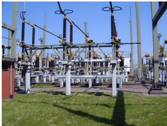
Figura 3.11: Subestación Reductora.
