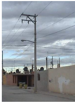
Figura 3.23: Red aérea de distribución de Baja Tensión.
