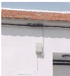
Figura 4.8: CGP en fachada con acometida aérea.
