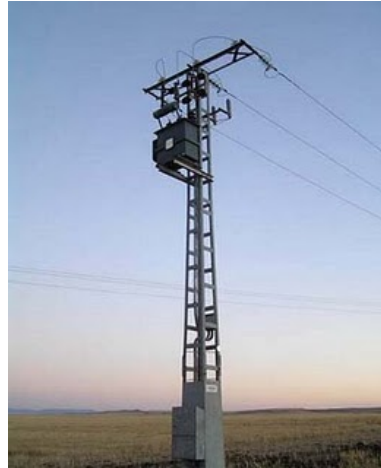
Figura 3.13: Centro de transformación a intemperie.
