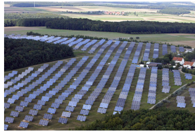
Figura 3.7: Estructura con varios paneles solares de una central fotovoltaica.
