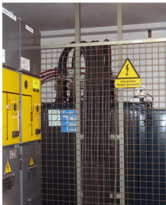
Figura 3.15: Enrejado de protección en el interior del centro de transformación.
