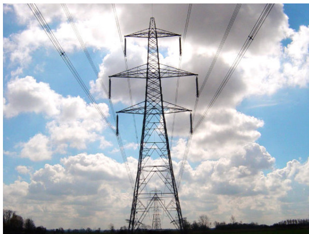
Figura 3.10: Red de transporte de Alta Tensión.
