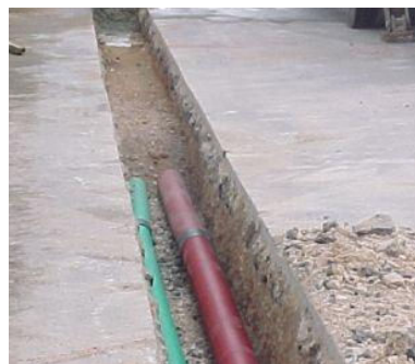
Figura 3.26: Red de distribución subterránea bajo tubo.
