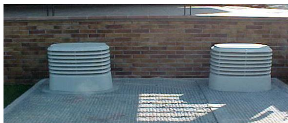
Figura 3.18: Ventilación y acceso a CT subterráneo.
