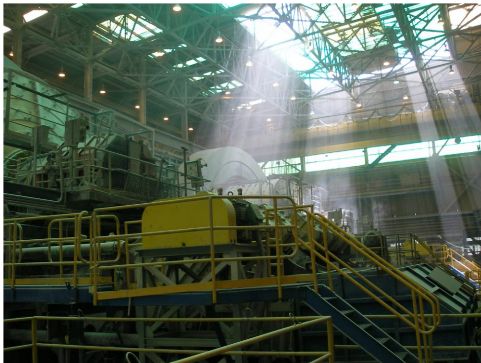
Fig. 4.5: Planta de Molienda (Foto propia).
