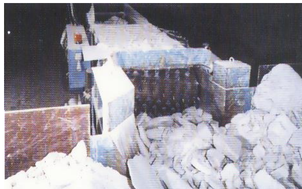
Fig. 3.60: Triturador de cilindro y transportador de racletas triturando material a pie de obra (Cortesía de Mackina-Westfalia).
